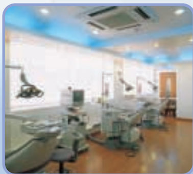
kaseta z 4-stronnym wypływem powietrza
