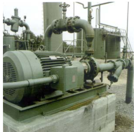
Regulacja wydajności pompy może się odbywać poprzez zmianę prędkości silnika. Płynną regulację prędkości umożliwia przemiennik częstotliwości.
